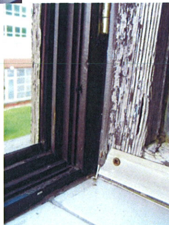
Tokelmozdulás, faszerkezeti repedés
