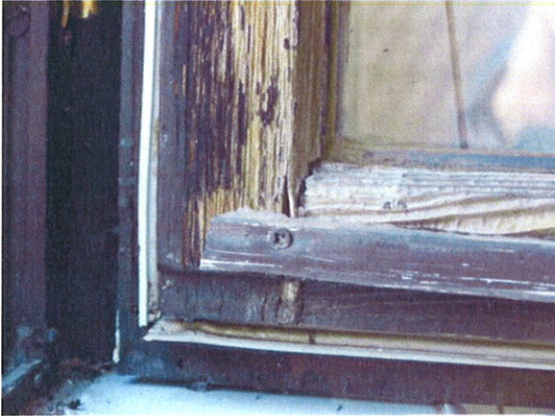
Ablakszárny, faszerkezeti repedés
