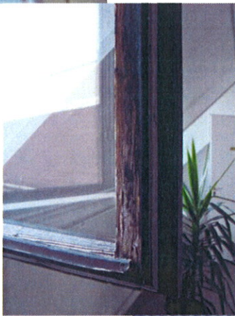
Ablakszárny, faszerkezeti repedés
