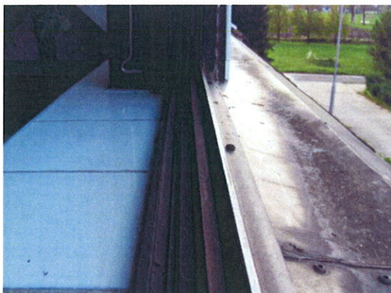
Szakszerűtlen párkánylemezelés
